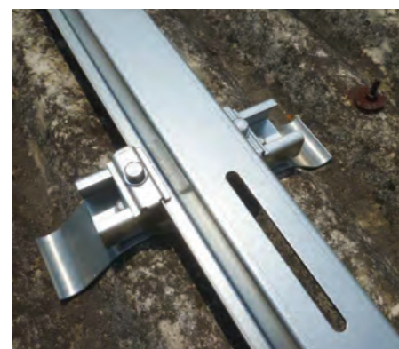
ハットラック押え金具施工断面
